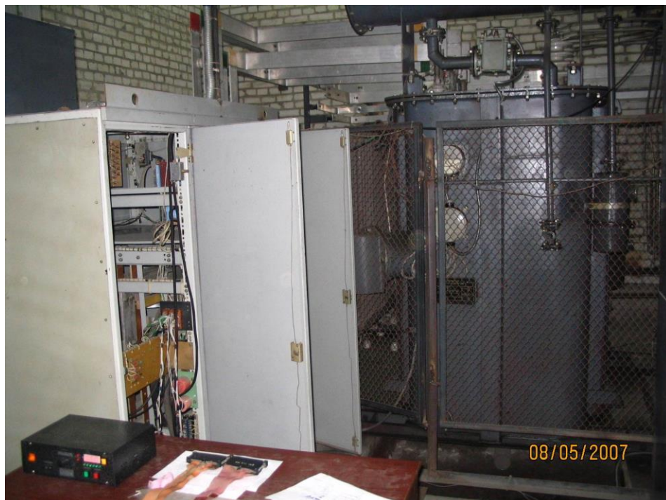
Рис.6.20 Блок управління у складі штатних високовольтних джерел живлення
