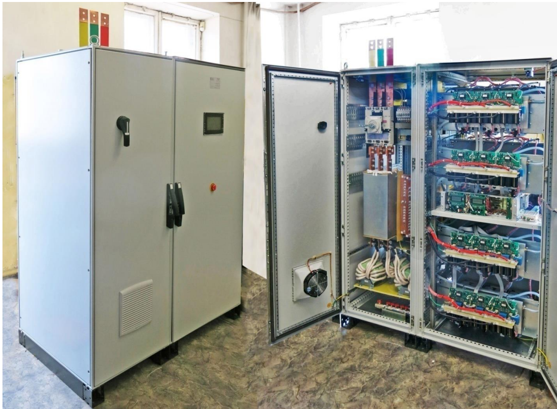
Рис. 6.37 Високовольтне джерело живлення електронного нагріву ДЖЕН-500-
