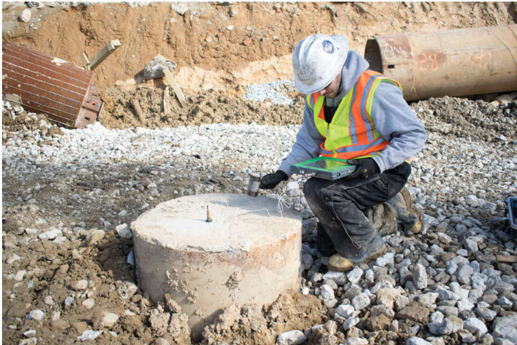
Рис. 1.13 Обстеження буроінжекційної палі на будівельному об'єкті
