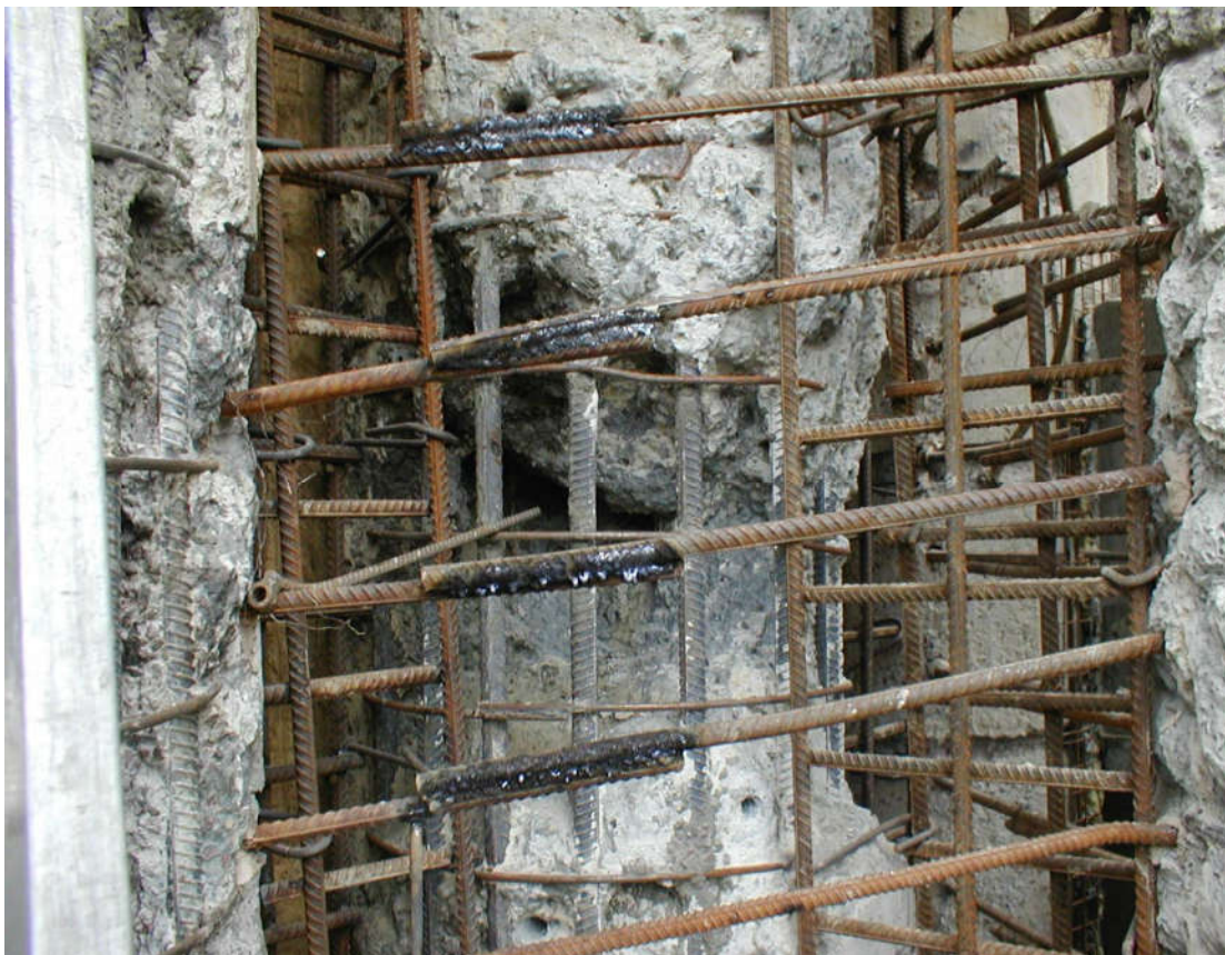
Рис.1.7 Неприпустима шийка стовбуру БНП.
