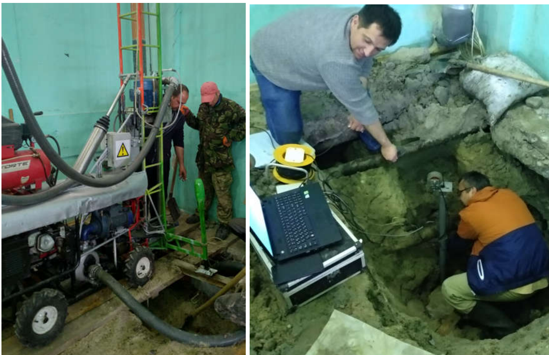
Рис. 4.15 Процес улаштування каналу доступу (а) та проведення обстежень комплексним акустичним методом(б)
