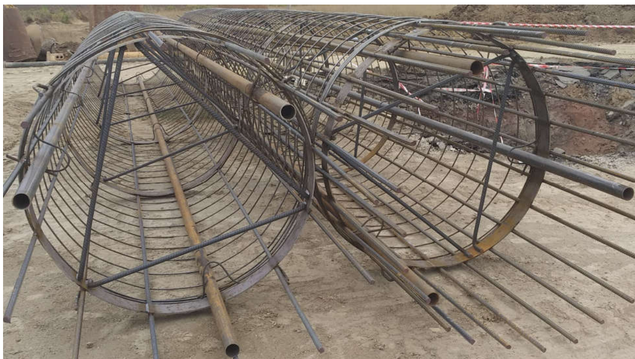
Рис. 4.11 Арматурні каркаси бурових стовпів з закріпленими каналами доступу
