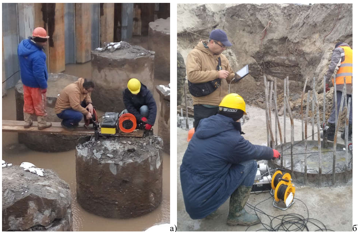
Рис. 4.12 Обстеження бурових стовпів співробітниками НДЛ "ДАКіС" на новому будівництві мостового переходу в Туркменістані на річці Амудар'я та Подольсько-Воскресеньському мостовому переході у м. Києві
