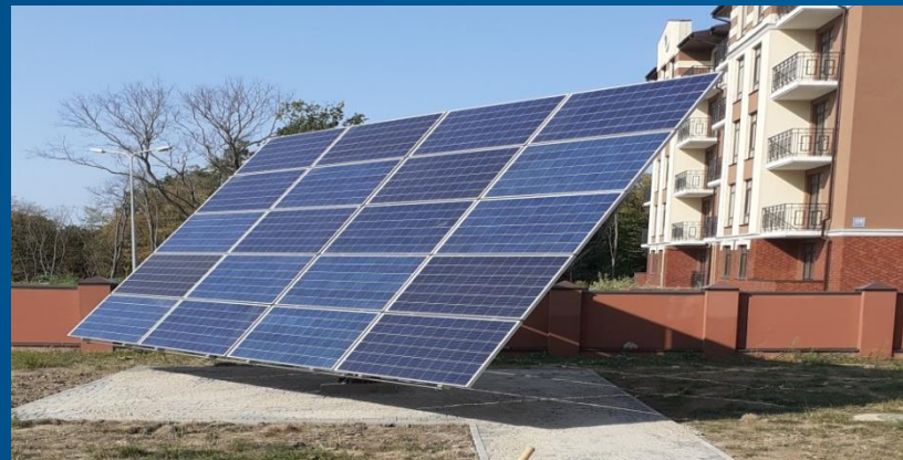
Двоосьова трекерна фотоелектрична система
