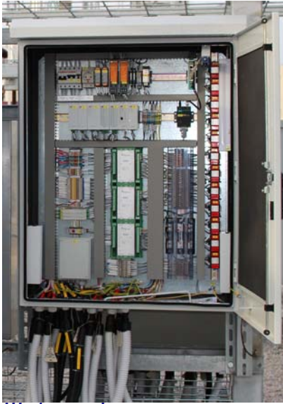
Шафа моніторингу елегазових вимикачів
